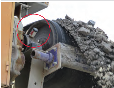
Stehlagerschmierung einer Förderbandanlage
