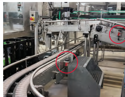
Kettenschmierung Kastentransport nach dem Einpacker und der Vollkistenkontrolle
