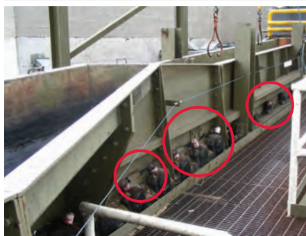
Lagerschmierung an der Baumsortierung
